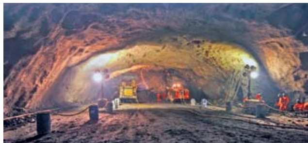
Perfuração do túnel de ligação entre o pátio de minério, ponte e píeres
