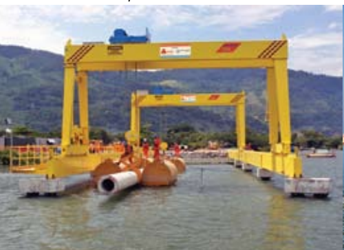
Porto de embarque de estacas e pré-moldados para as obras off shore
