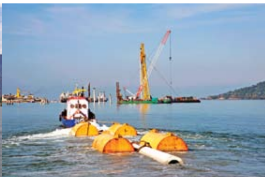
Transporte de estacas de concreto protendido utilizadas nas obras off shore
