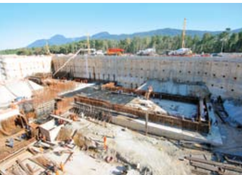
Parede diafragma para instalação dos viradores de vagões
