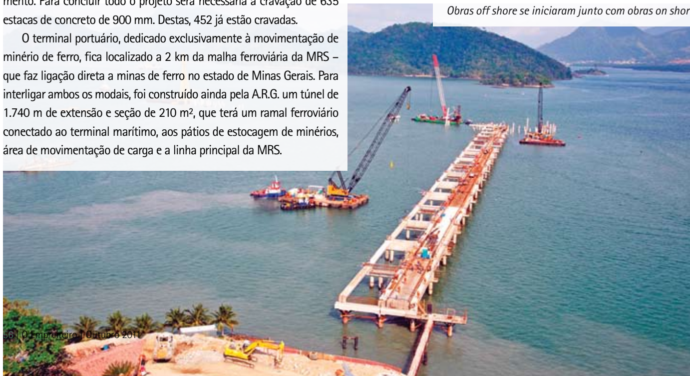
Obras off shore se iniciaram junto com obras on shore
