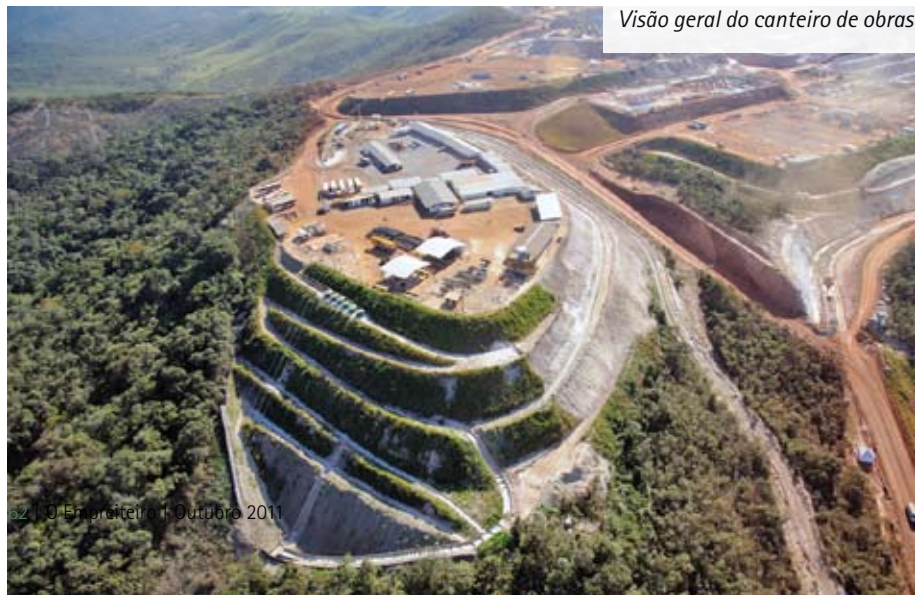
Visão geral do canteiro de obras
