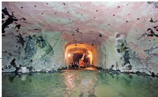
Vista dos tirantes de ancoragem do túnel com extensão de 1.740 metros
