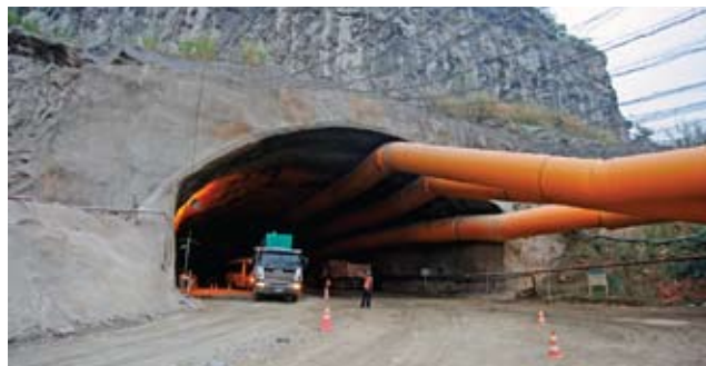
Emboque do túnel com seção de 210 m 2
